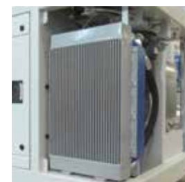
Scambiatore di calore aria/olio (std) Air/oil heat exchanger (std)
